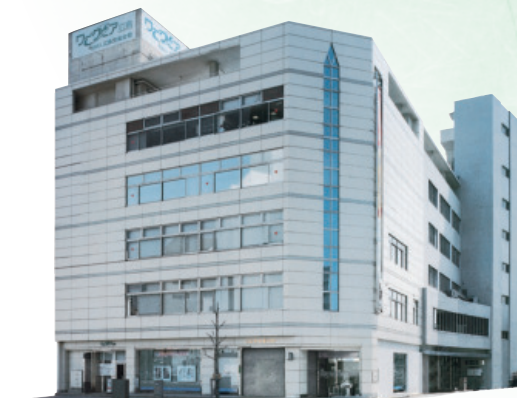
広島労働会館
